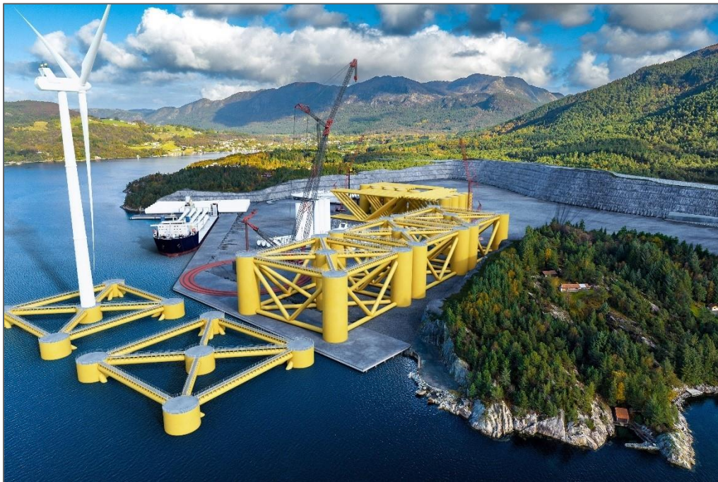
Figur 8 I denne figuren er illustrasjonen i figur 3 vist i 3D frå sjøen. Fem havvindturbinar under arbeid samtidig ved utvikling av fase 2. Delar til tre komplette møller (15MW turbinar) ligg lagra på området. Eit fartøy ligg til kai for å levere nye delar. I tillegg er 3D-modell for aktuelt industriareal i fase 3 lagt inn.
