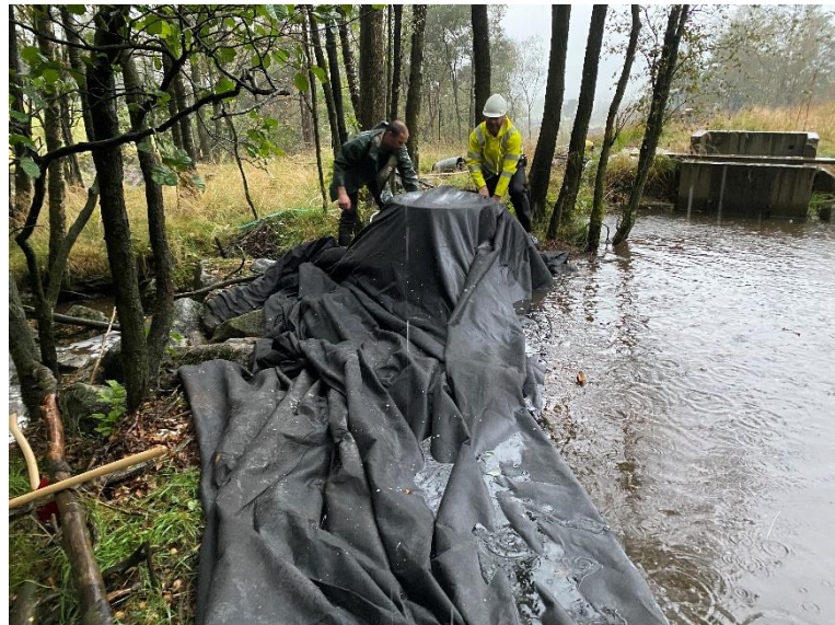
Det ble tilført noe ekstra stein under duken, før duken ble lagt over. På toppen ble det plassert stein/jordmasser.
