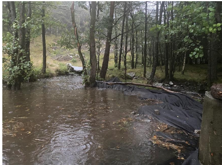
Ved å tette terskelen helt, steg vannet kjapt i inntaksdammen. Vannet slår da tilbake gjennom stikkrennen, og over i elveløpet man ser i bakgrunnen.
